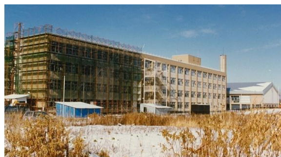
昭和 58 年 5 月 23 日 第 2 期工事着工
